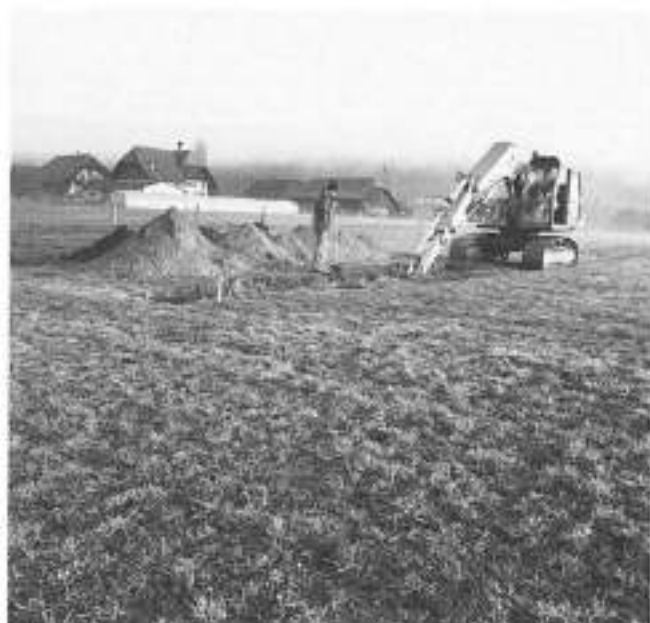
Abb. 5: Gampelen-Jänet 3 1987. Baggersondierungen, Sondierschnitt 1.
