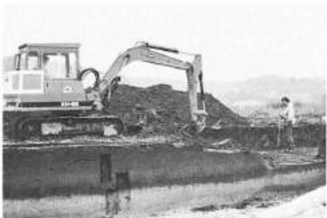
Abb. 6: Gampelen-Jänet 3 1987. Abtrag der Deckschichten mit Hilfe des Baggers im Bereich der Quadratmeter 130–140/566–574. Im Profil ist eine der Pollenproben-Entnahmestellen erkennbar.
